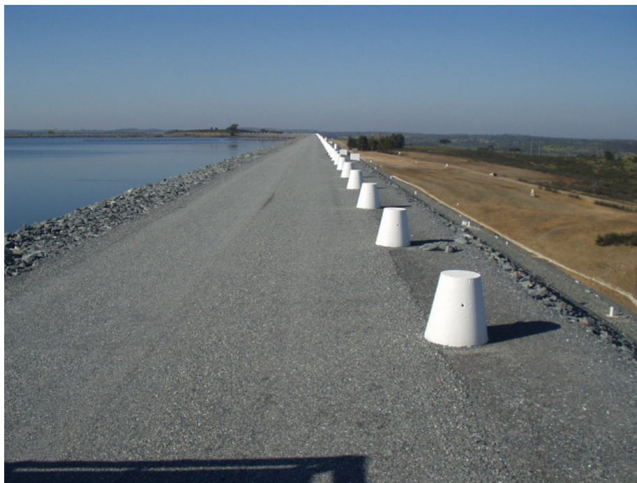
Figura 6: Coroamento da barragem com os marcos de protecção
