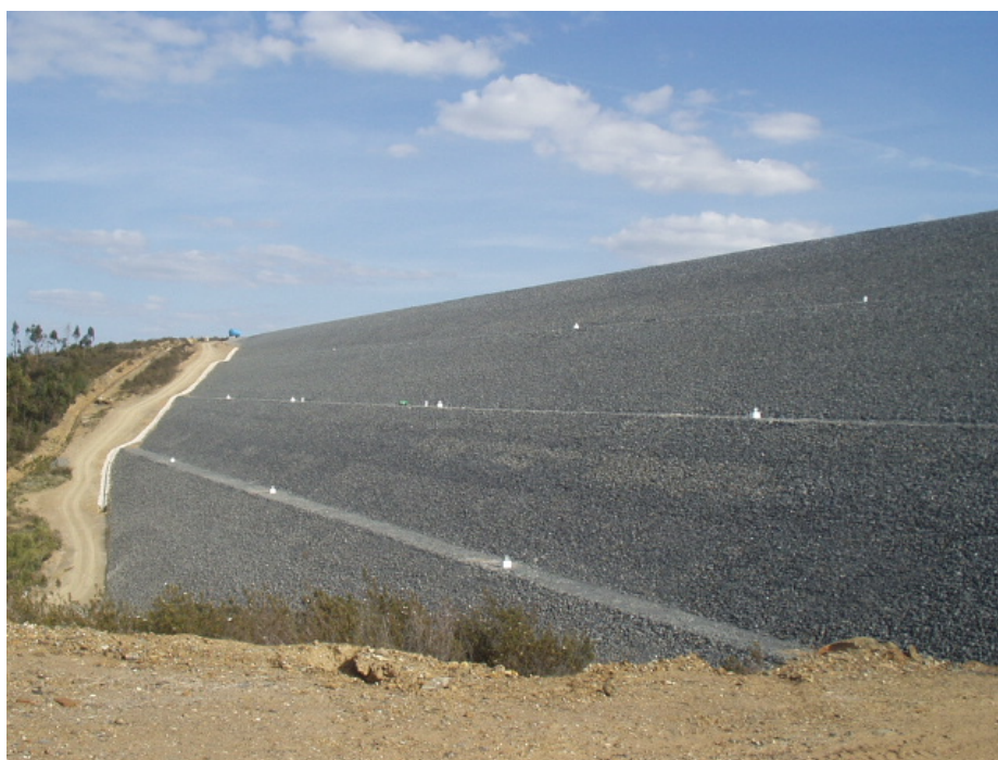
Figura 2: Corpo Principal da barragem, visto do encontro esquerdo
