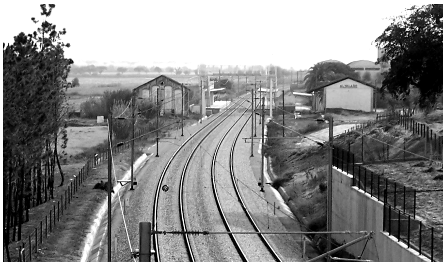
Figura 2 - Aspecto presente da Estação de Alvalade do Sado
