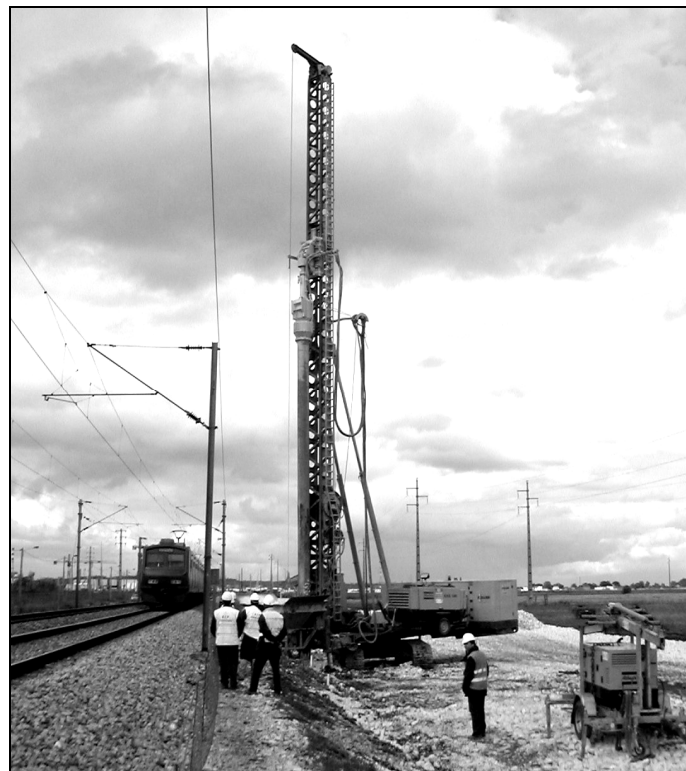
Figura 5 – Execução de colunas de brita no Apeadeiro da Castanheira do Ribatejo (futura Estação V. F. Xira Norte)
