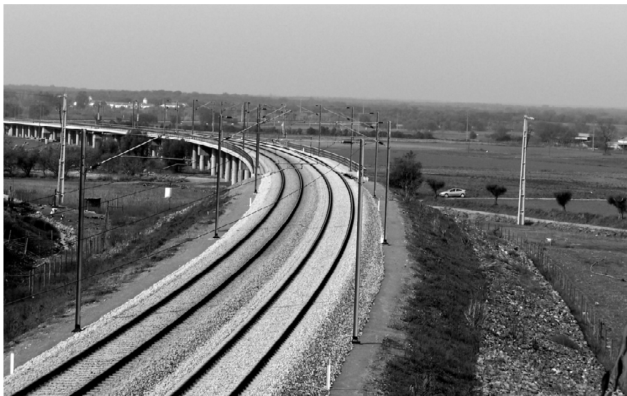
Figura 3 - Aspecto presente do Encontro Sul do Viaduto de Alvalade do Sado
