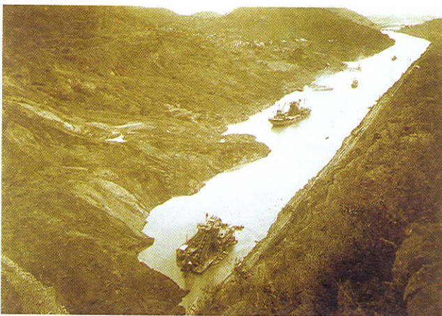
Figura 14.1 Los deslizamientos en las laderas del canal de Panamá retrasaron los trabajos durante años.
