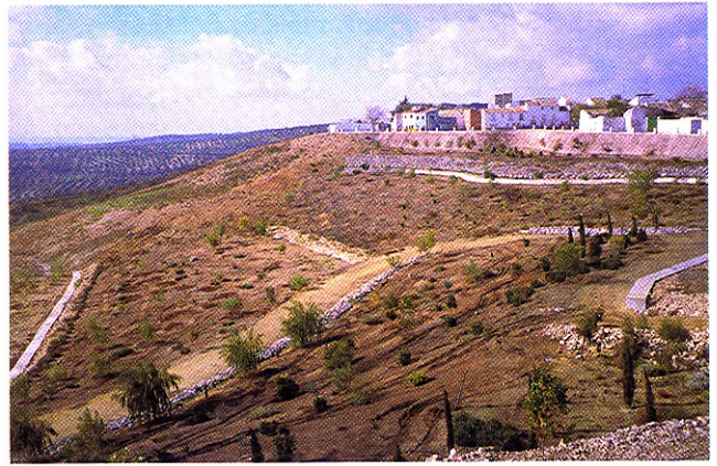
Figura 14.29 Vista de parte superior de la ladera de Benamejé tras las obras de estabilización (foto M. Ferrer).
