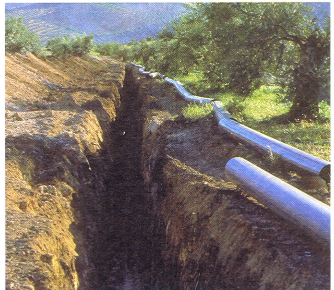
Figura 14.30 Excavación de una zanja de drenaje perimetral para estabilización de un deslizamiento (foto M. Ferrer).
