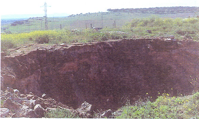
Figura 14.39 Socavón producido por el hundimiento de una antigua galería minera en la zona kárstica de El Calerizo, Cáceres (cortesía de J. J. Durán).
