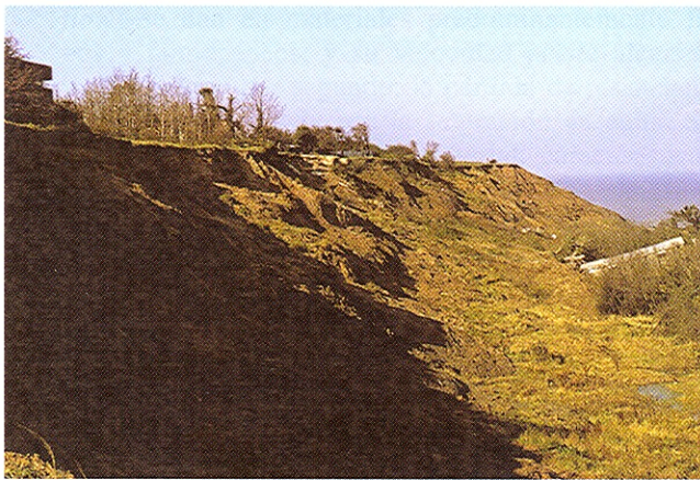
Figura 14.4 Vista de la parte superior de un deslizamiento rotacional en arcillas; obsérvese la grieta de tracción y la inclinación del terreno en sentido contrario a la ladera, con formación de charcos; Warden Point Cliff, Inglaterra (foto L. González de Vallejo).
