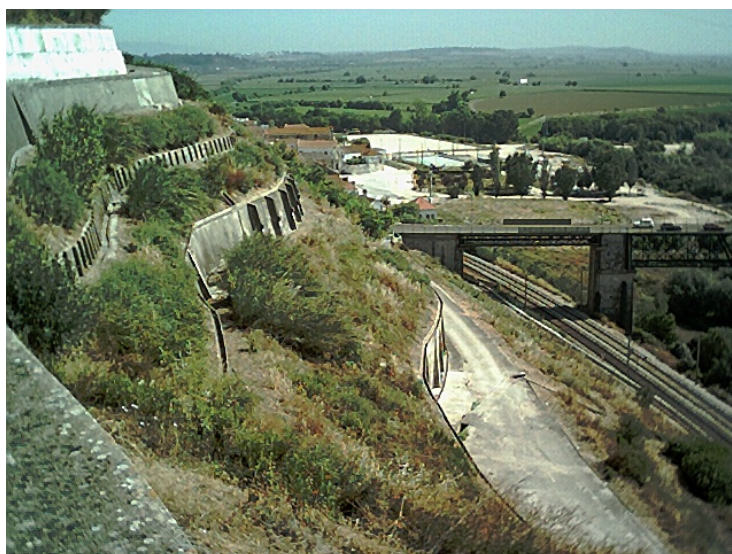
Figura 1 - Aspecto da via férrea intercalada entre os taludes de Santarém e o Rio Tejo
