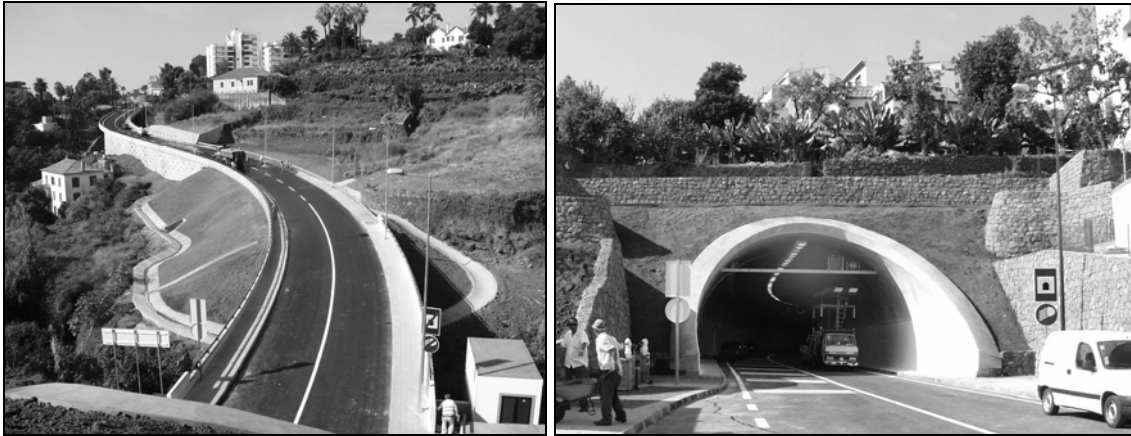
Figura 7 – Aspectos gerais da obra concluída.
