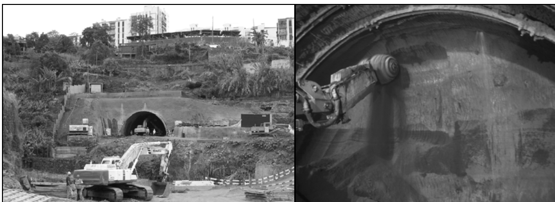
Figura 5 – Emboquilhamento Poente. 1ª fase de escavação do túnel (esquerda), frente de escavação em tufos avermelhados e piroclastos friáveis.
