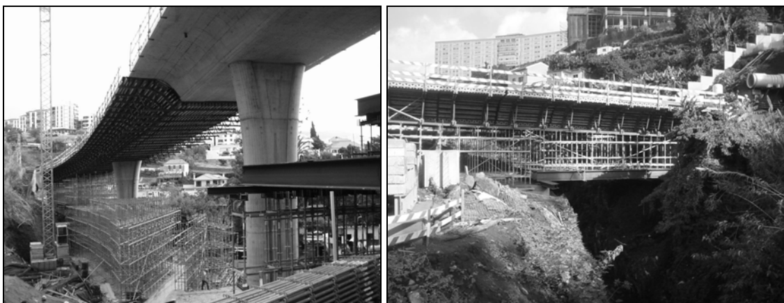
Figura 4 – Viaduto da Magnólia (esquerda) e Ponte sobre o Ribeiro Seco.
