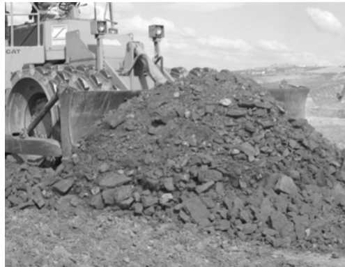
Figura 3 – Cilindro utilizado e aspecto das margas durante a compactação.
