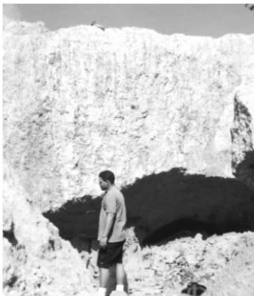
Figura 8 - Processo erosivo da camada inferior que retira a sustentação da camada concrecionária, resultando na queda de blocos.
