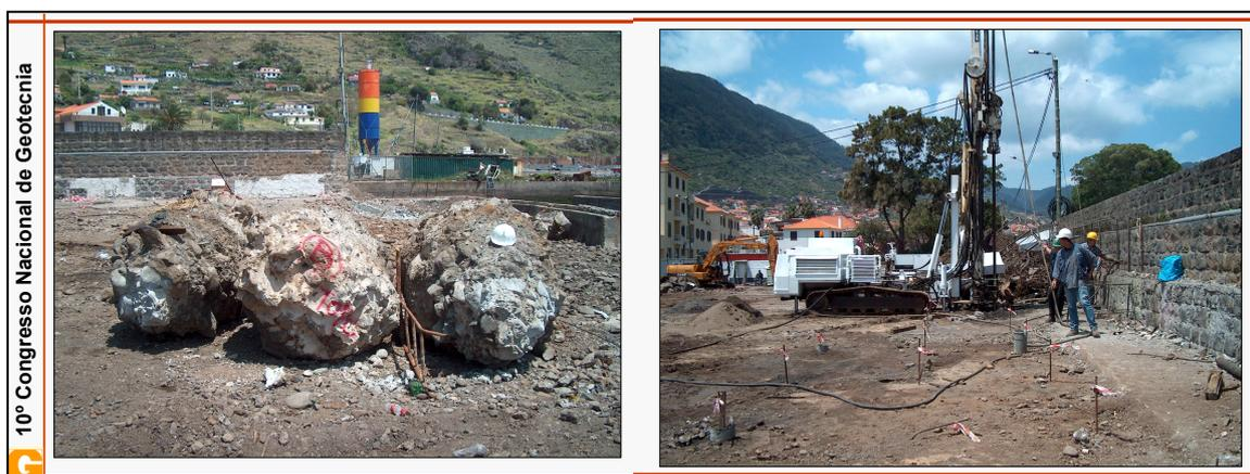
Figura 4 – Vista das colunas teste e da execução de colunas junto ao muro existente
