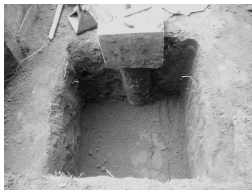
Foto 6 – Vista da abertura da vala.
