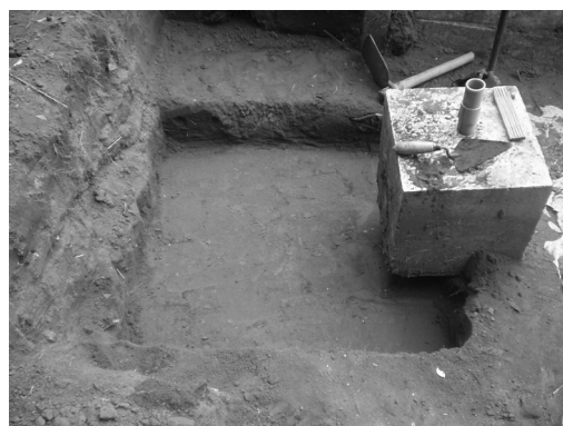
Foto 8 – Vista do reforço executado.
