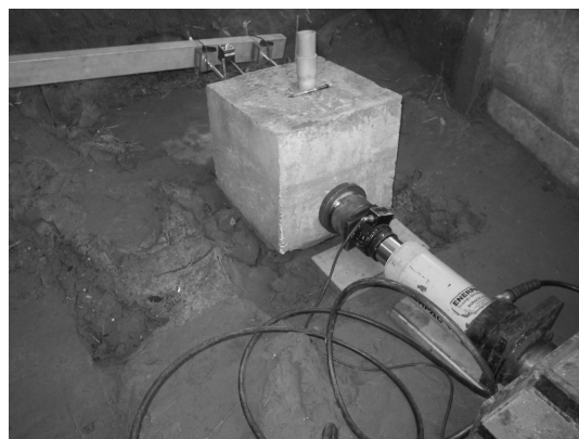
Foto 5 – Vista de uma prova de carga.
