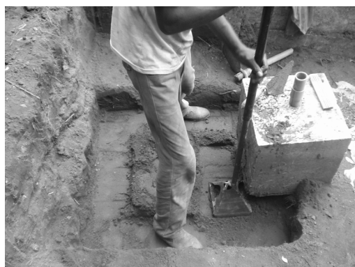
Foto 7 – Trabalhos de substituição do solo.
