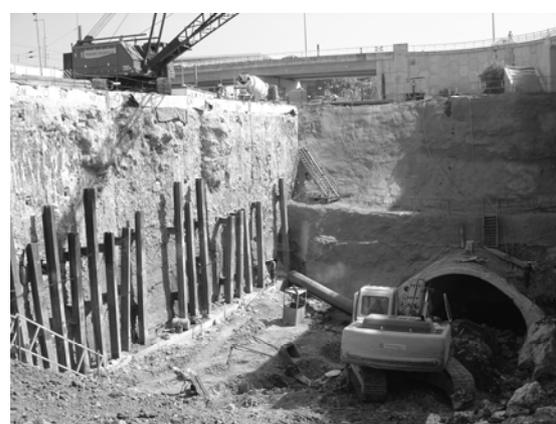
Figura 7 – Execução faseada do recalce da contenção (confrontação Sudeste) e escavação/contenção já totalmente executada (confrontação Noroeste) - (fotografias tiradas em Maio de 2004)
