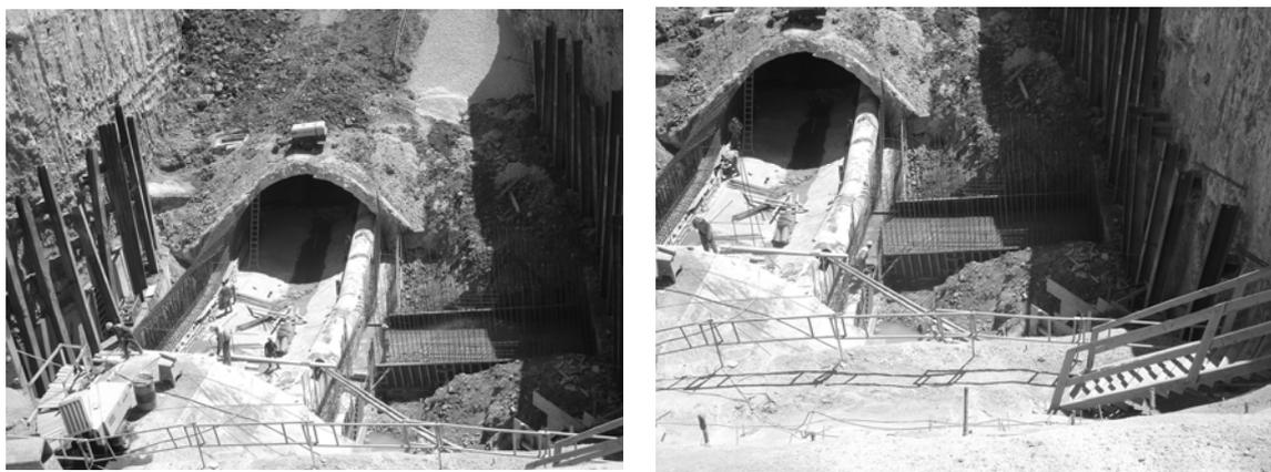
Figura 10 – Aspecto do final da escavação (fase de reconstrução da estrutura do Caneiro – fotografias tiradas em Julho de 2004)
