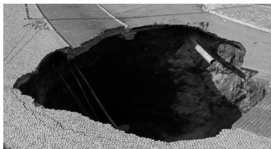
Figura 1 - “Cratera” gerada no pavimento após aluimento de terras originado pela rotura do hasteal direito do Caneiro (fotografias tiradas em Novembro de 2003, logo após o acidente)
