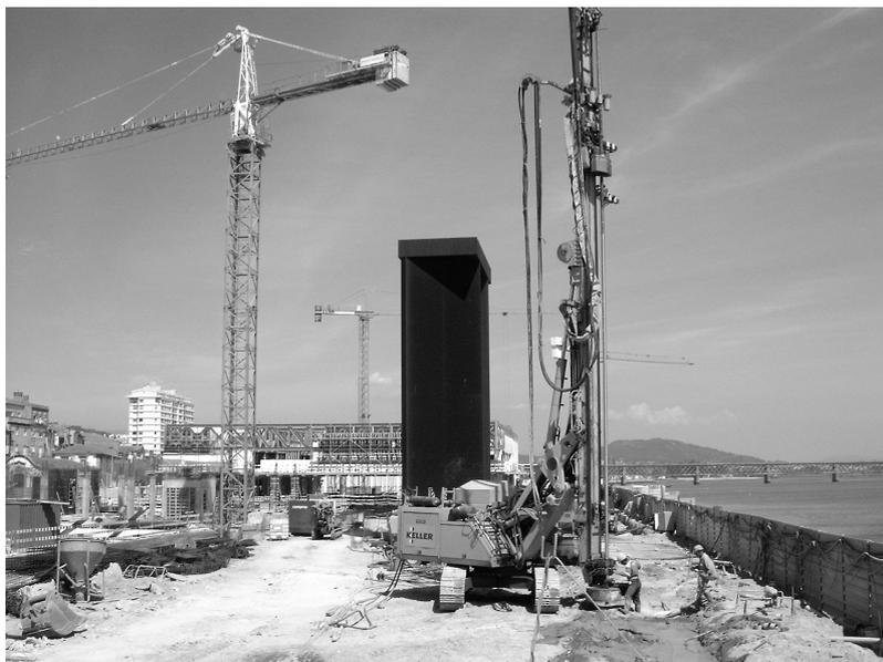
Figura 1 – Execução da cortina de jet grouting
