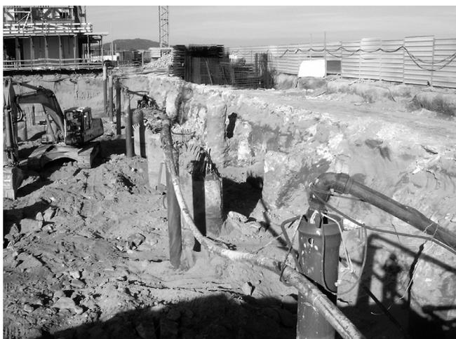
Figura 6 – Aspecto da cortina de jet grouting e furos de captação de água após a escavação com cerca de 4,0 m de profundidade
