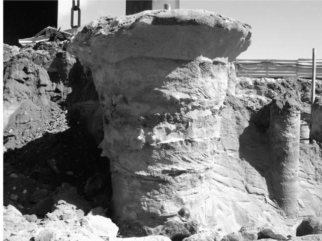
Figura 7 – Coluna de JG  $\phi$  1,8 m reforçada com tubo de microestaca de  $\phi$  127 mm
