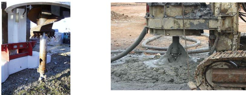
Fig. 5 – Prolongador para betonagem e descida da ferramenta de perfuração
