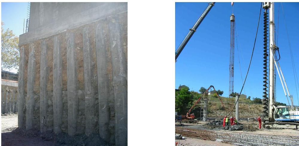
Fig. 1 – Contenção por cortina de estacas e colocação da armadura em estaca de fundação
