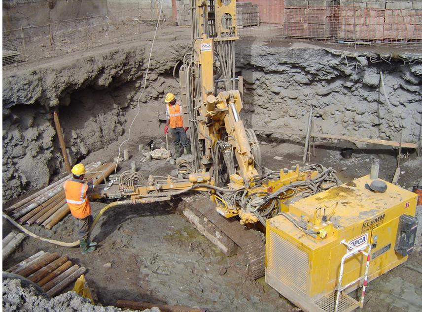
Figura 4 – Execução de Microestacas
