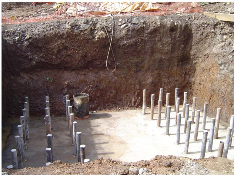
Figura 6 – Pilar fundado em 48 Microestacas
