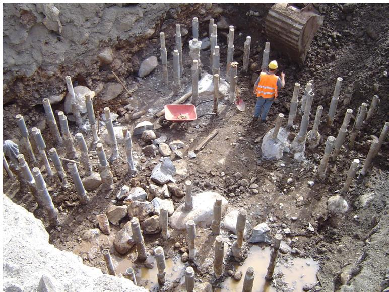
Figura 5 – Pilar fundado em 64 Microestacas
