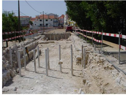
Figura 21 – Microestacas executadas
