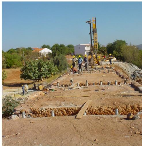
Figuras 11 e 12 – Fotos da execução das microestacas
