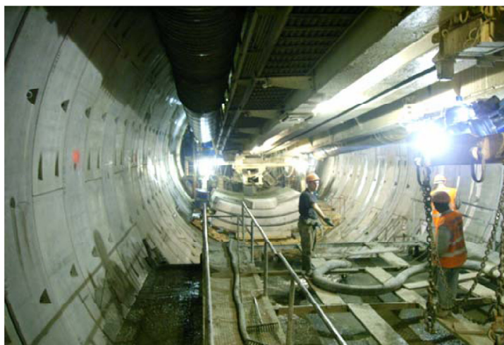
Figura 2 – Aspecto da execução do túnel no segmento Alameda - Saldanha
