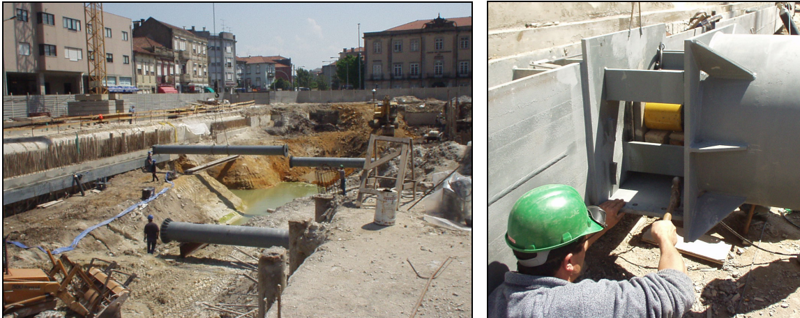
Figura 2 – Instalação das escoras e do macaco hidráulico para aplicação do pré-esforço
