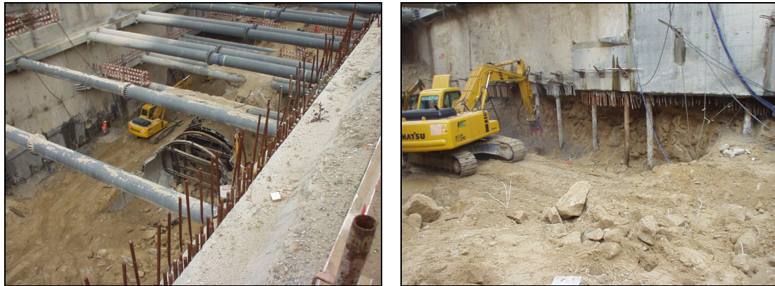
Figura 6 – Desmonte das aduelas do túnel e recalce das paredes moldadas
