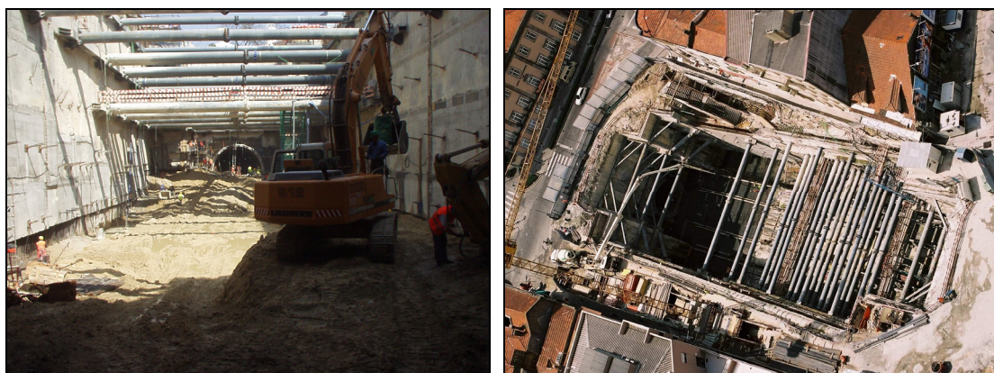
Figura 8 – Interior do recinto após atingida a cota de fundo da escavação e vista aérea correspondente
